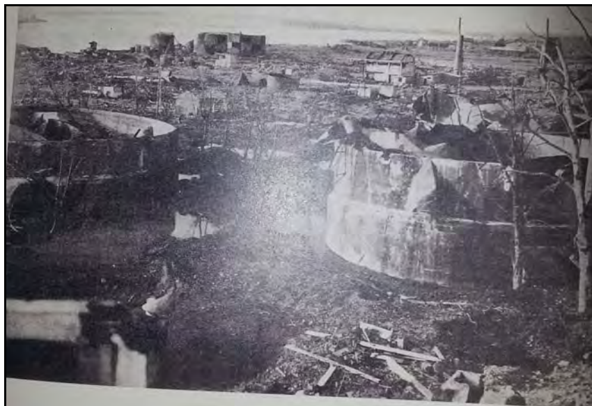
Figure n°6 : Photographie de l'usine après les bombardements de 1940 (15.117.RA.001.01.fig07)
