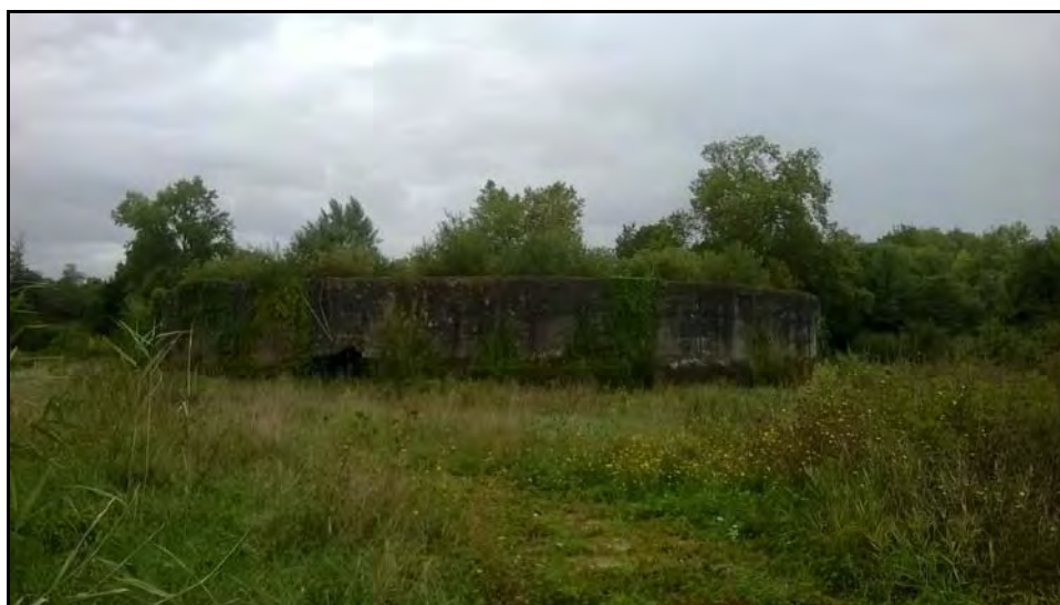
Figure n°28 : Ancienne cuve de stockage (15.117.RA.001.01.fig29)
