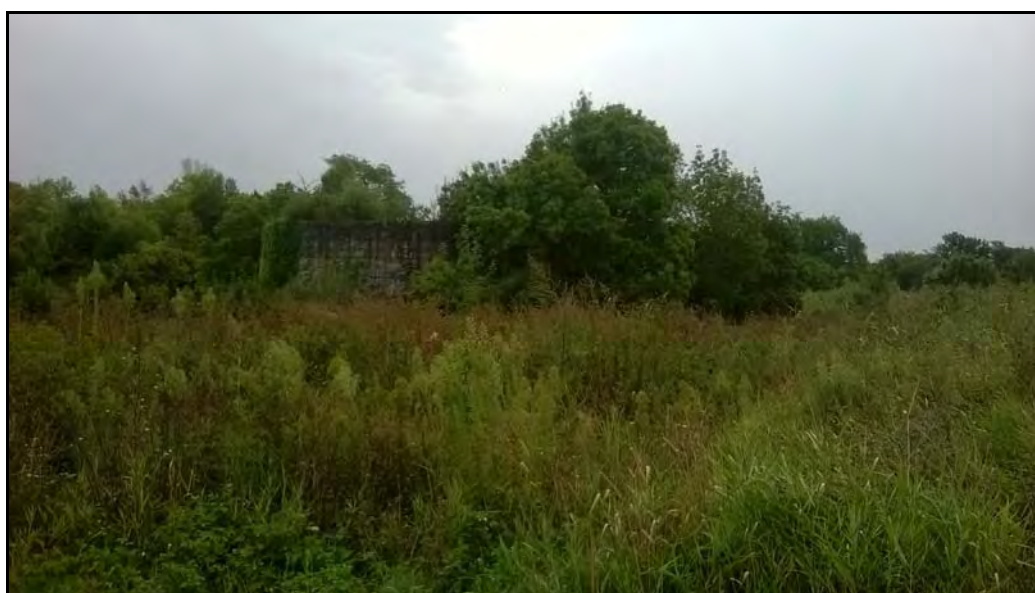
Figure n°29 : Ancienne cuve de stockage (15.117.RA.001.01.fig30)
