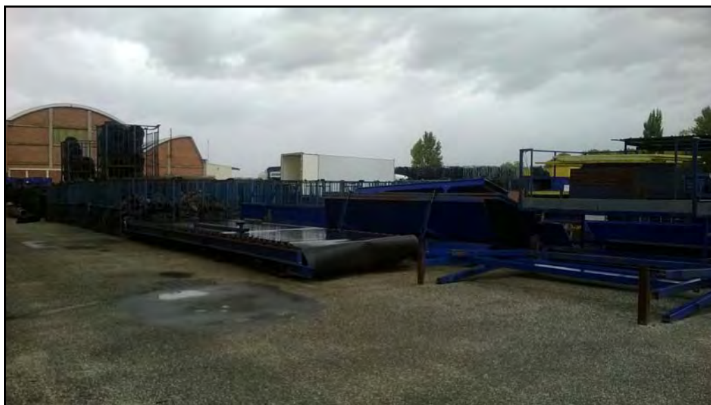
Figure n°24 : Bâtiment de la fin des années 50 (15.117.RA.001.01.fig25)
